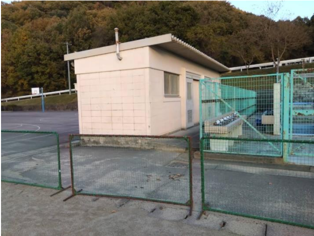
プール横のトイレ
