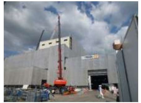
▲写真：工事中のクリーンセンター 9月29日撮影
